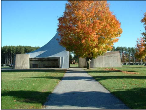
46. La trouée dans le bâtiment.
