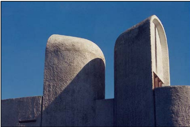
132. Détail de puits de lumière.
