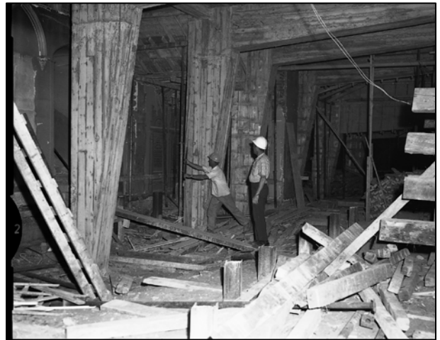
4. Travaux au sous-sol de la cathédrale, 1966.
