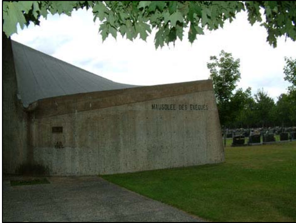
78. La toiture du mausolée.
