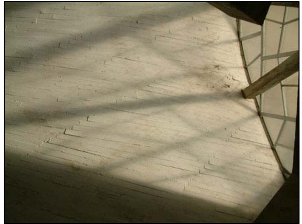
65. Paroi intérieure du voile mince en béton de la chapelle. L'éclairage met en relief les traces de décoffrage du béton.
