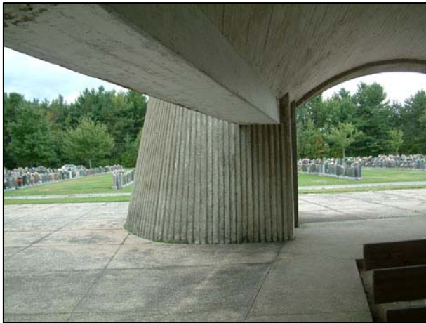
56. La sacristie supporte les poutres de rive.
