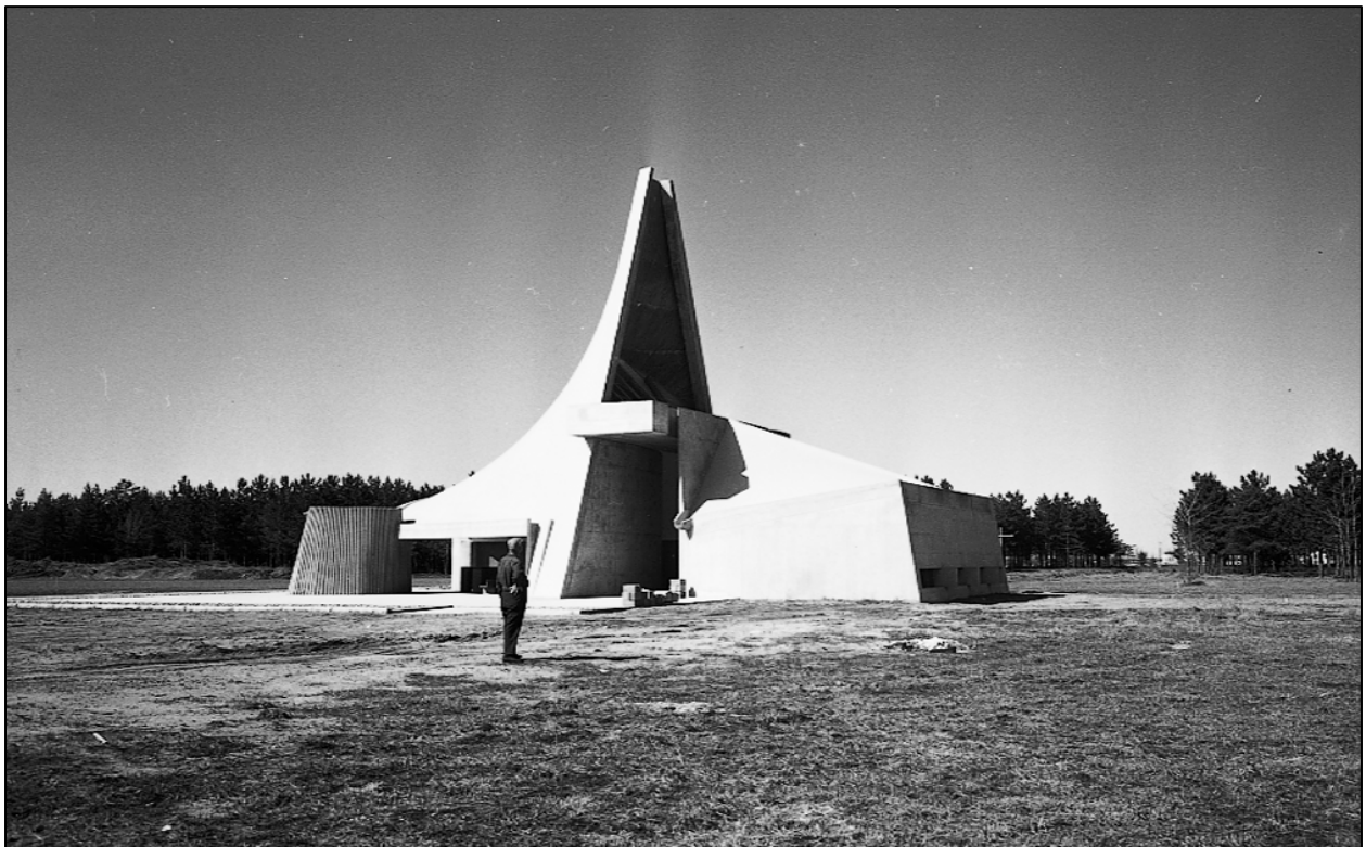
33. Le mausolée des évêques à la fin du chantier, 1967.
