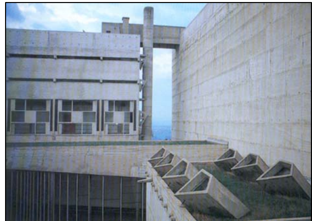
137. Détail architectural du couvent.
