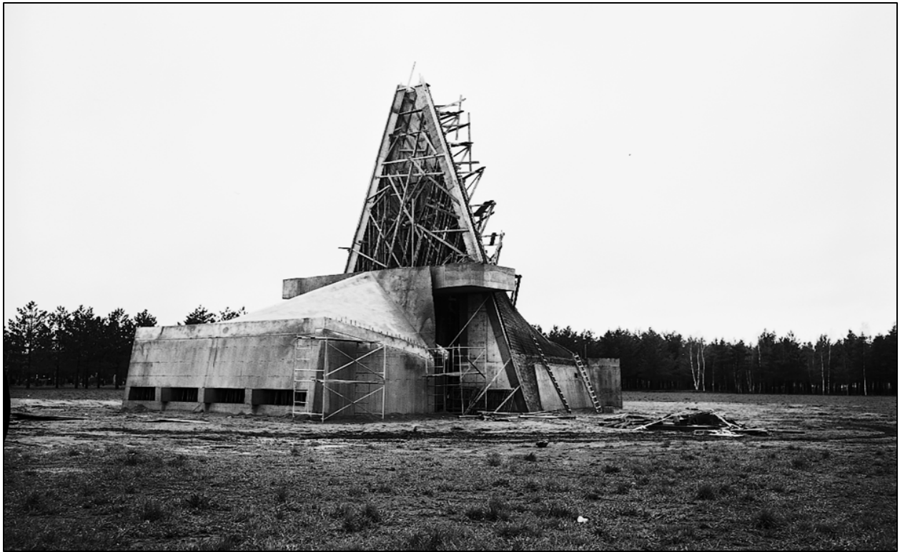
6. Le chantier de construction du mausolée des évêques, 1966.
