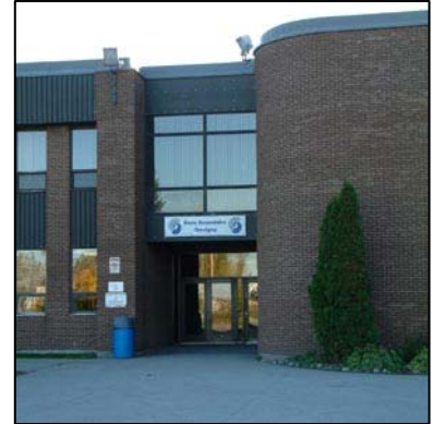
177. École secondaire Chavigny. Entrée principale, 2006.
