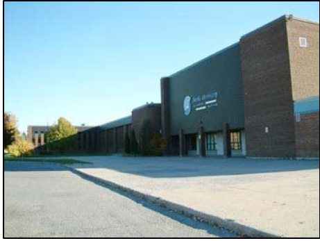
175. École secondaire Chavigny, Trois-Rivières-Ouest.
