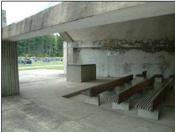
52. La nef et son autel surélevé en béton.
