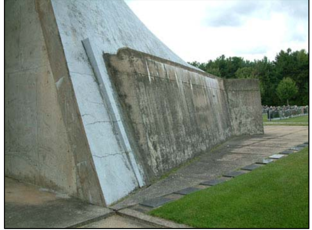
83. Le béton permet des formes inusitées. Détail des gouttières en béton.
