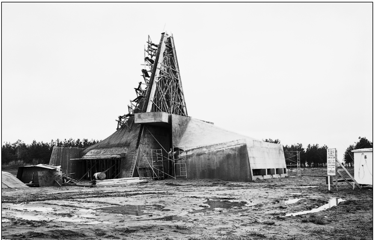
7. Le chantier de construction du mausolée des évêques, 1966.
