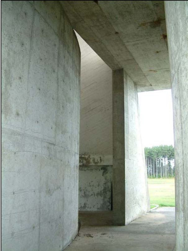
84. Le béton permet de réaliser autant des formes courbes que des éléments orthogonaux.
