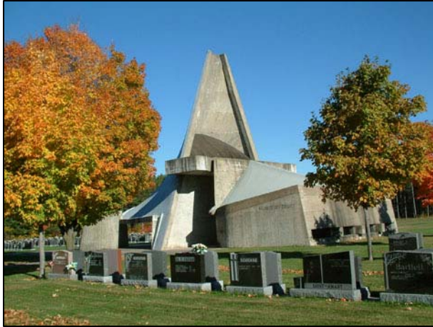
86. Le mausolée est déposé dans le cimetière telle une sculpture dans un parc.
