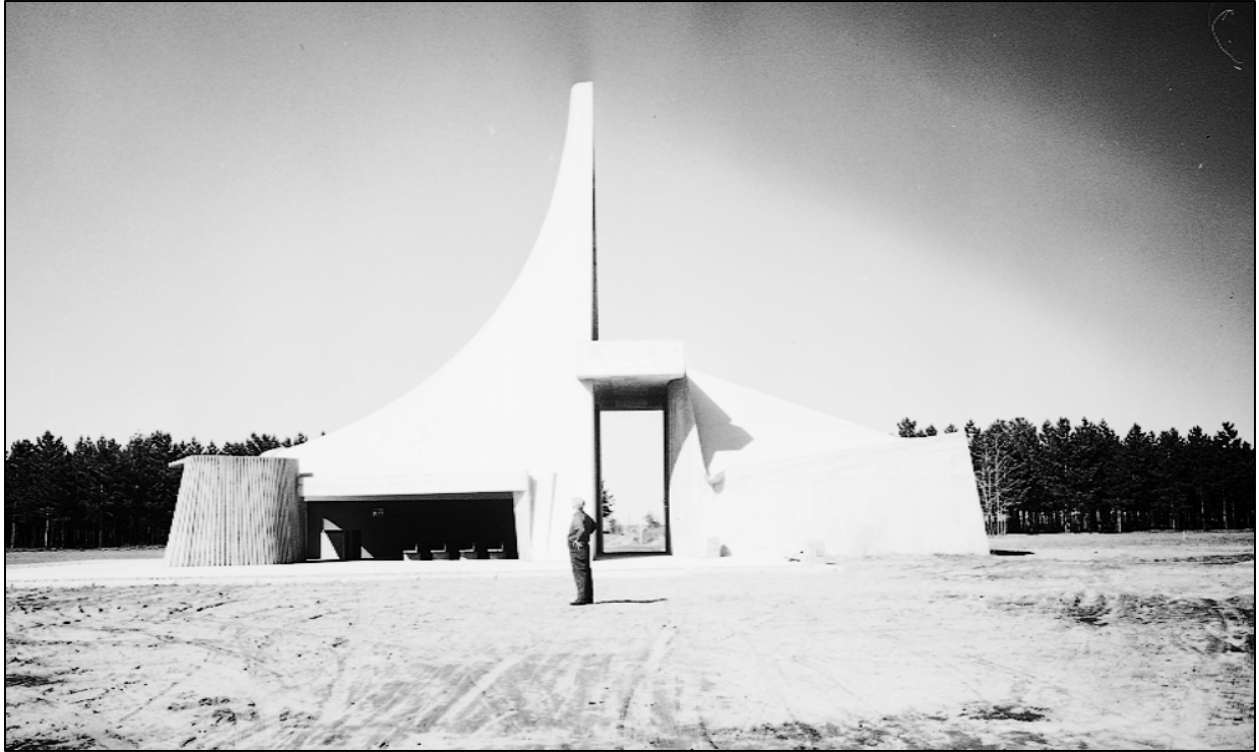
32. Le mausolée des évêques à la fin du chantier, 1967.
