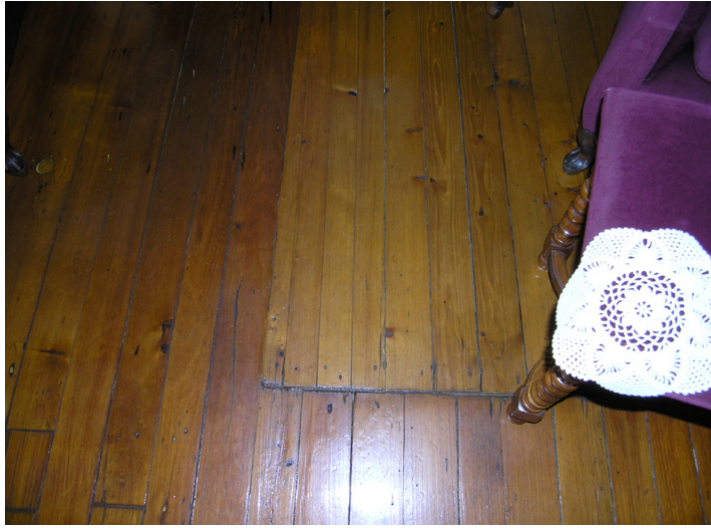
15. Le plancher à l'anglaise. Photo Camille Lapointe.
