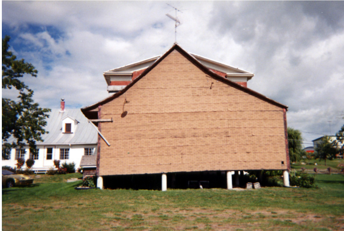
31. La forme du toit reflète la présence d'un backstore . Photo Camille Lapointe.
