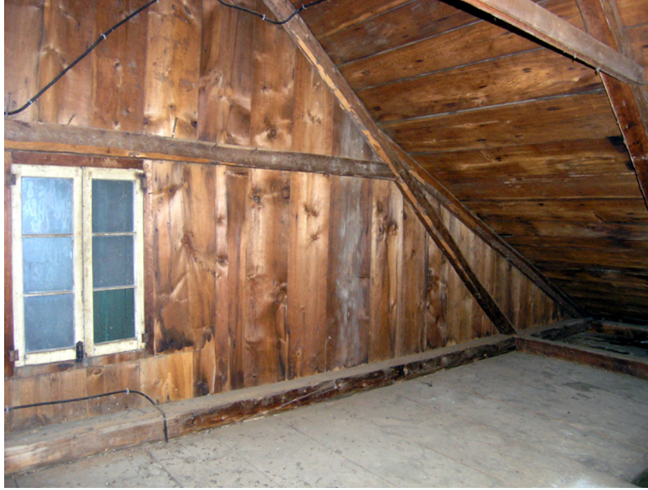
37. Détail de la charpente et fenêtre du côté non mitoyen. Photo Camille Lapointe.
