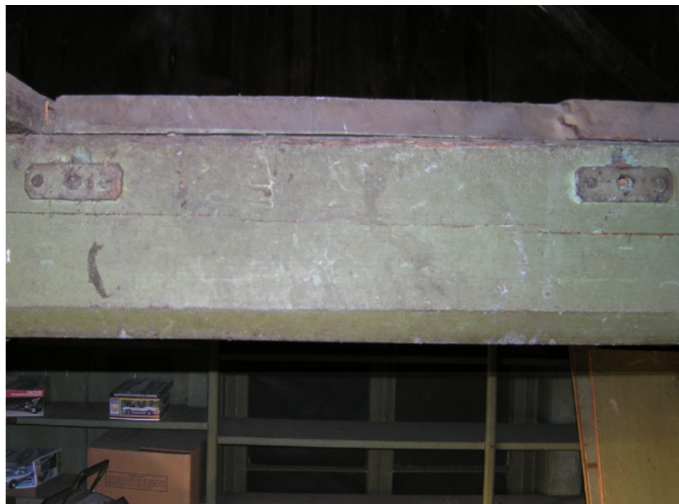
35. Embouffetage du plancher du haut et solive chanfreinée. Photo Camille Lapointe.
