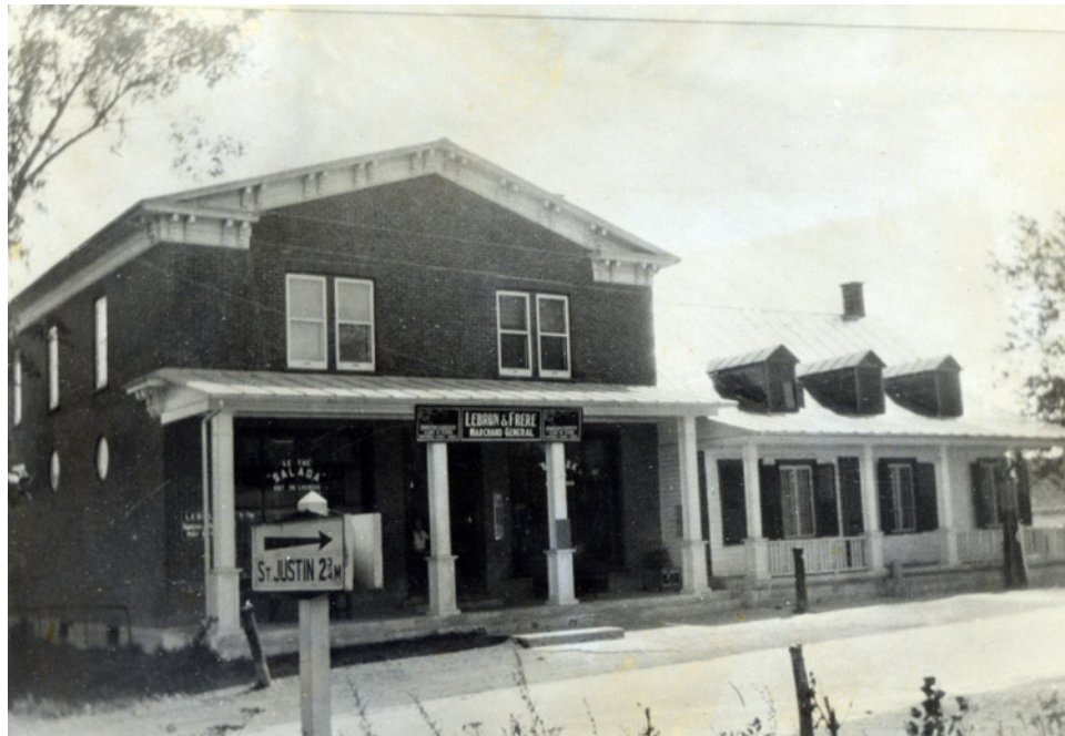
9. La façade après la construction des galeries. Photo collection Serge C. Martin et Gisèle Saucier.
