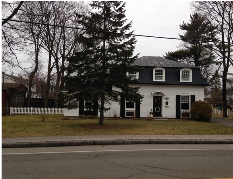
La Maison du cocher Chemin Saint-Louis (secteur Sillery) Québec
