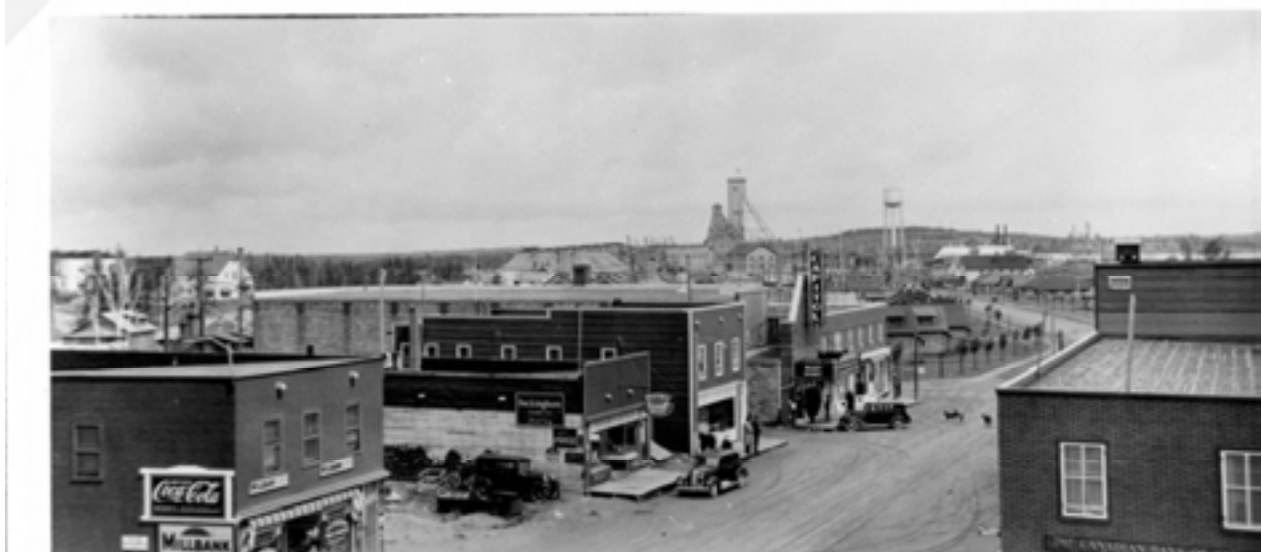
Figure 14. Vue des commerces de l'avenue Perreault
