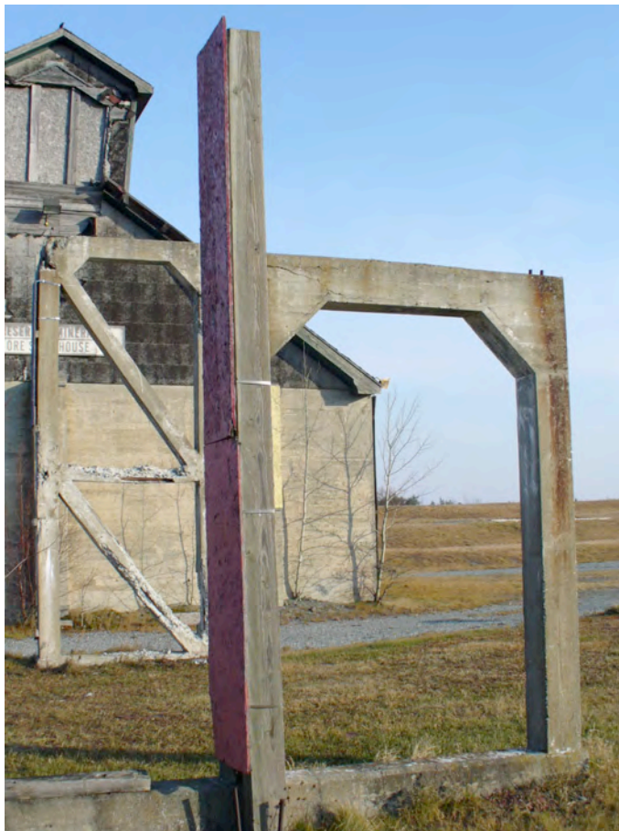
Photo 27. Supports du convoyeur vers la réserve à minerais
