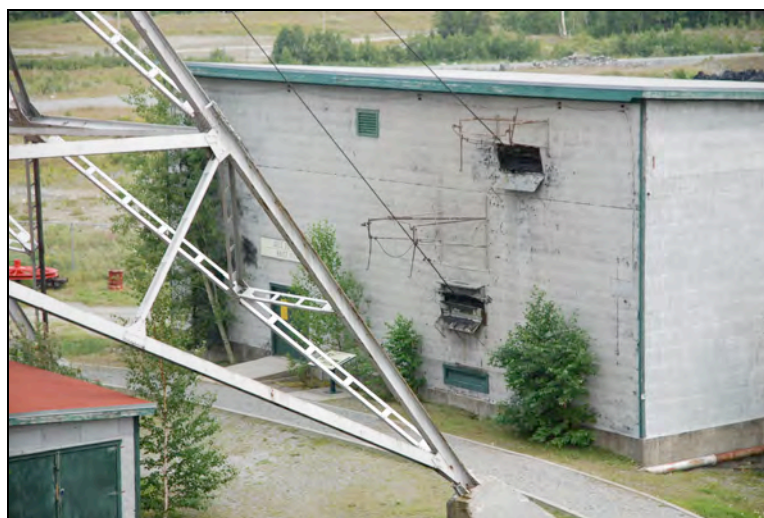
Photo 24. Bâtiment du treuil, du côté du chevalement n° 7
