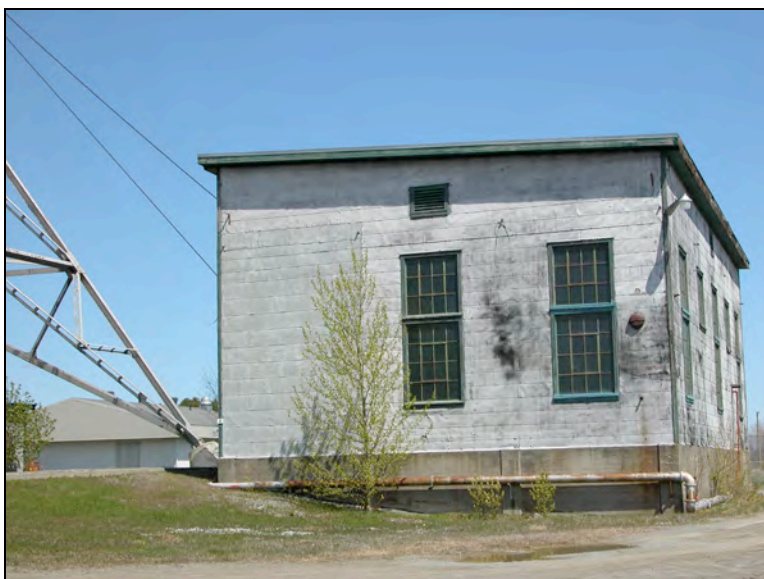
Photo 23. Bâtiment du treuil, vu de l'ouest
