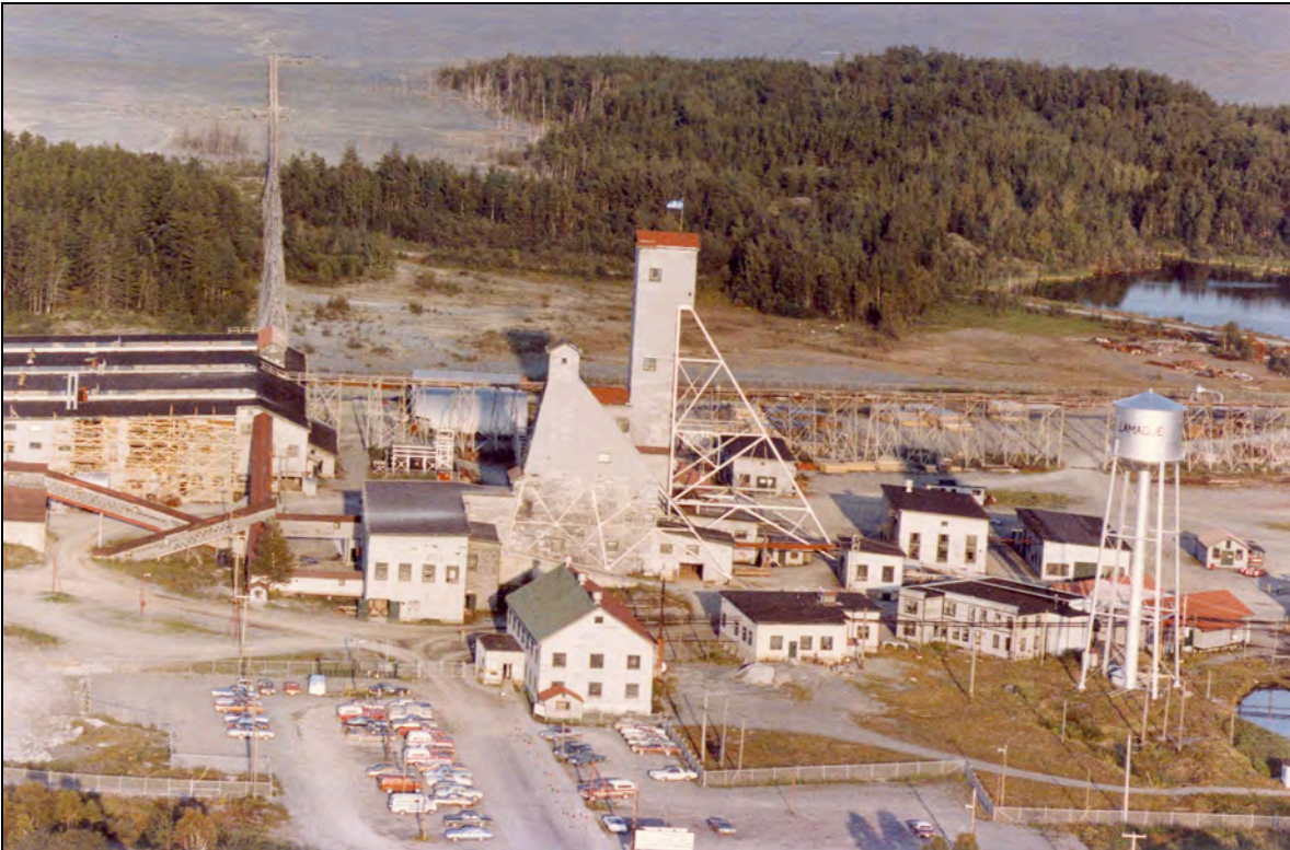
Photo 8. Bâtiments de la mine et clôture en 1989
