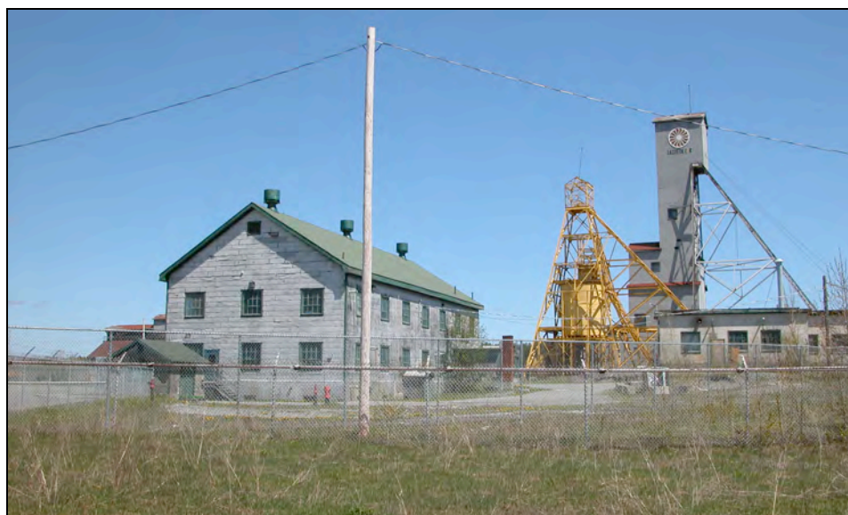
Photo 10. Clôtures actuelles du côté ouest du site
