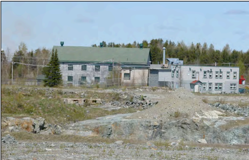
Photo 19. Autre vue à partir du secteur du puits n° 3
