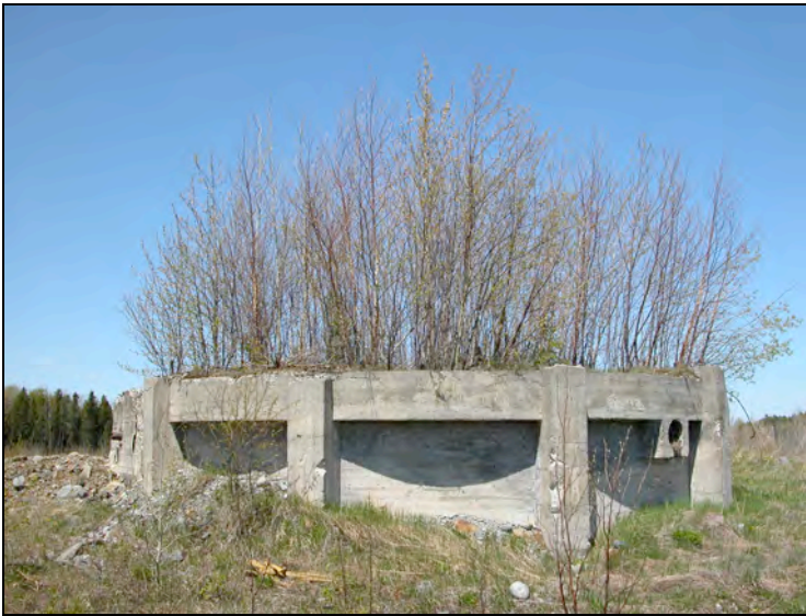
Photo 11. Fondations de l'ancien décanteur d'égout au sud de la fosse
