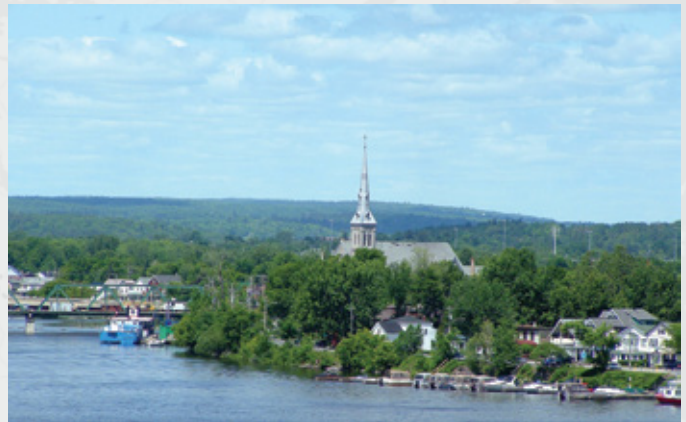
Site patrimonial Jacques-Cartier. Source : Sylvain Lizotte 2007 © MCC
