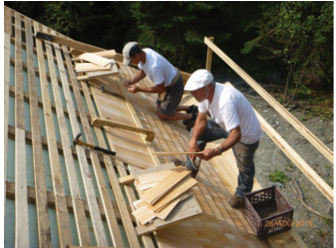
Exemple : En 2016, le Centre de conservation du Québec a publié Toit. Bois.Bardeau – Guide technique , portant sur la transmission du savoir-faire traditionnel de la couverture en bardeaux de bois, un ouvrage de référence destiné aux propriétaires. Source : © Donald Ouellet 2015
