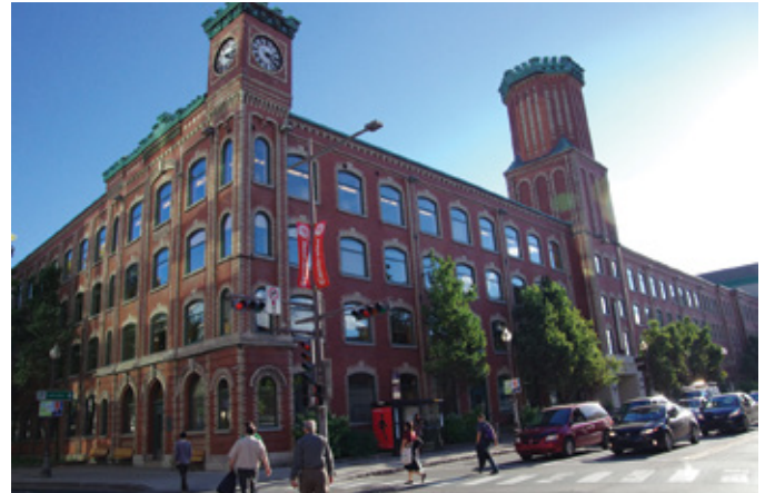
L'industrie Dominion Corset à Québec rénovée et recyclée en bureaux municipaux. Source : © Vivre en Ville, tous droits réservés
