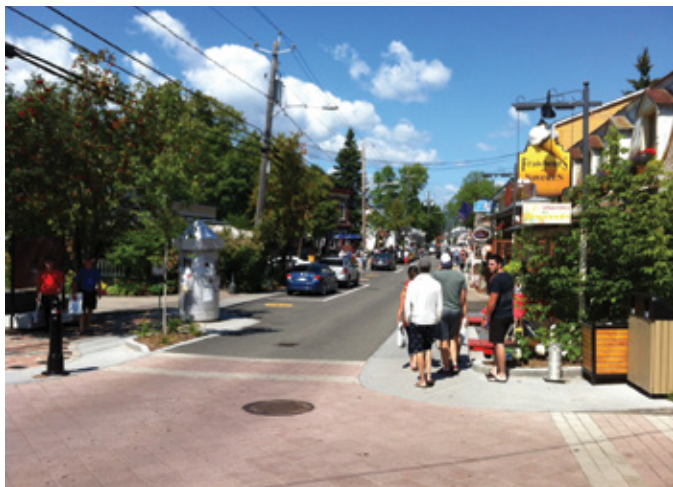
Exemple : La Ville de Baie-Saint-Paul a élargi et abaissé les trottoirs bordant la rue Saint-Jean-Baptiste pour mieux accueillir les visiteurs. L'aménagement des intersections contribue à rendre la rue principale non seulement plus sécuritaire, mais aussi distinctive. Source : © Vivre en Ville, tous droits réservés
